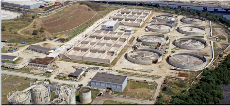
A ETE Alegria é o maior complexo de saneamento urbano do Rio de Janeiro, fundamental para a recuperação ambiental da Baía de Guanabara.
